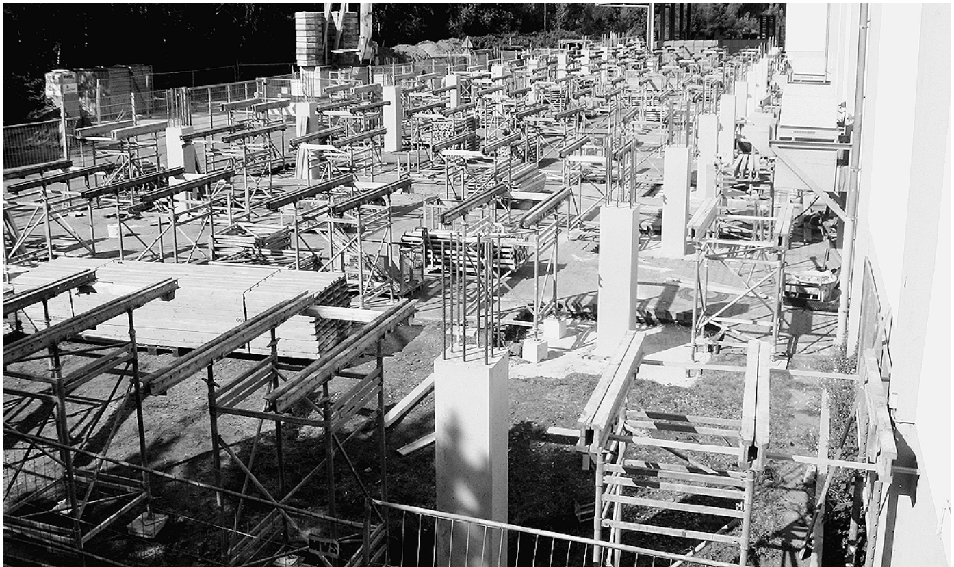
Bei der Erweiterung eines Industriegebäudes war eine geeignete Notunterstützung gefordert, um zwölf Betonunterzüge mit einer Gesamtlänge von 17 m und einem Querschnitt von 50 x 100 cm zu sichern.
