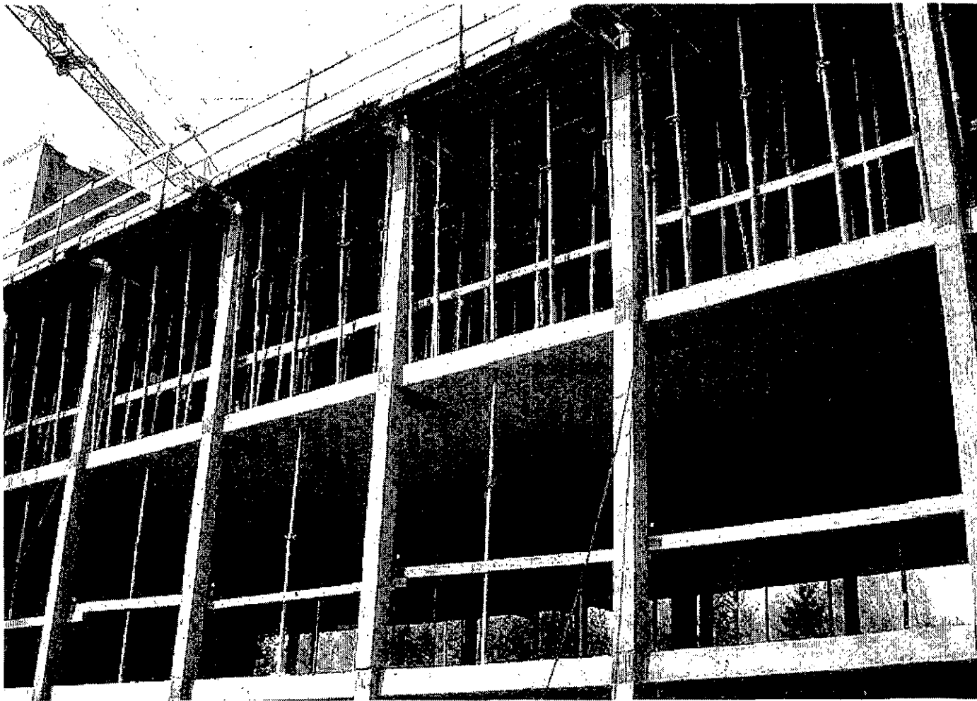
Einsatz auf der Schalungsbaustelle Biomedizinisches Forschungszentrum Marburg.
