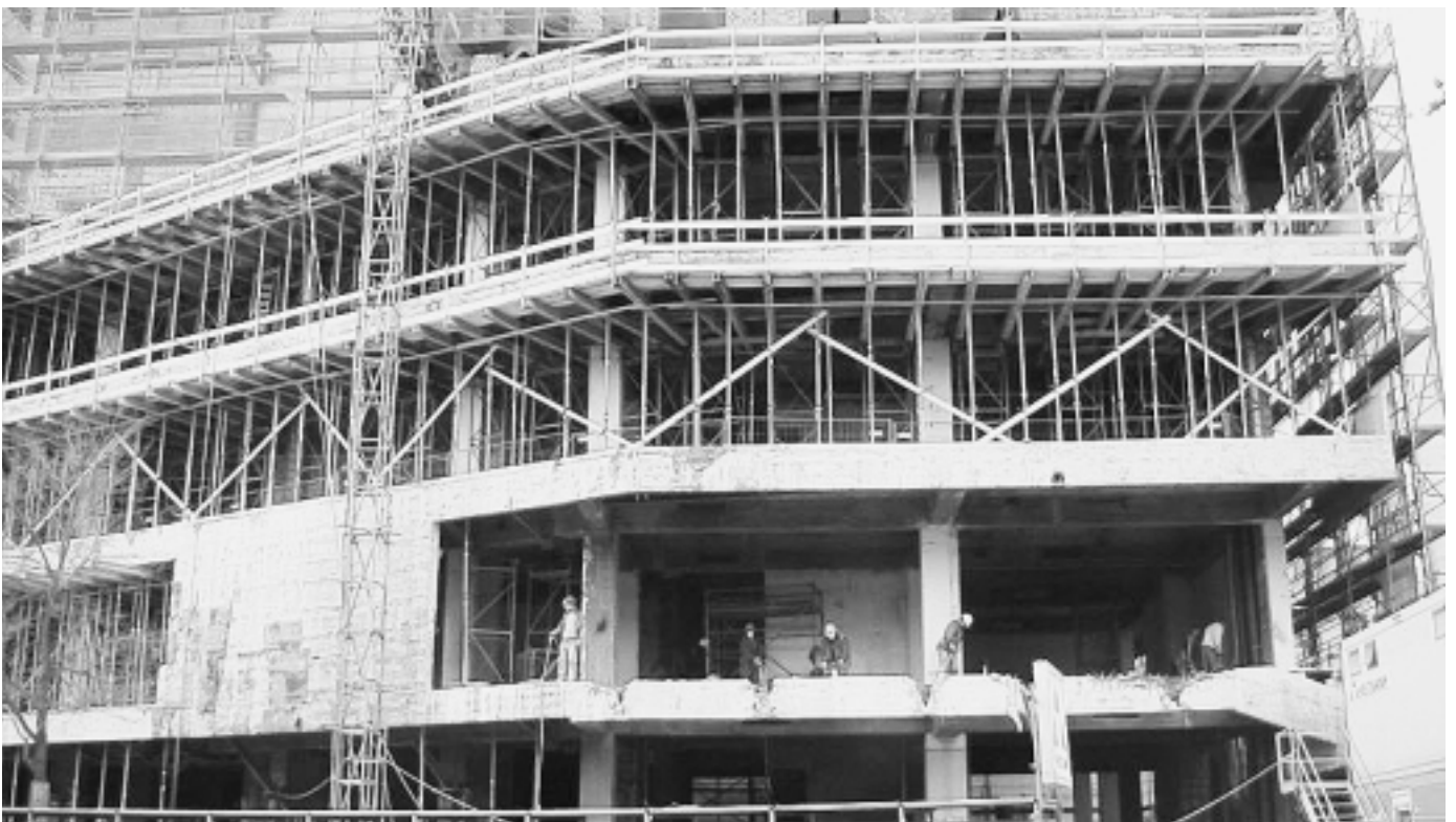
Da auf der Baustelle für die Sicherungsarbeiten kein Kran zur Verfügung stand, musste ein leichter Auf- und Abbau der Geräte von Hand möglich sein. In Absprache mit der beauftragten Baufirma entwickelte der Schalungslieferant daher eine Konstruktion aus Rahmenstützen ID15, Stahlrohrstützen und Holzträgern sowie Geländerhaltern. Foto: Walter Lerch Bau- und Industriebedarf
