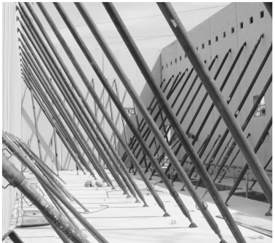
Insgesamt sind 60 Schrägstützen im Einsatz, einzelne Fertigteile haben ein Gewicht bis 6,5 t. Foto: Lerch
