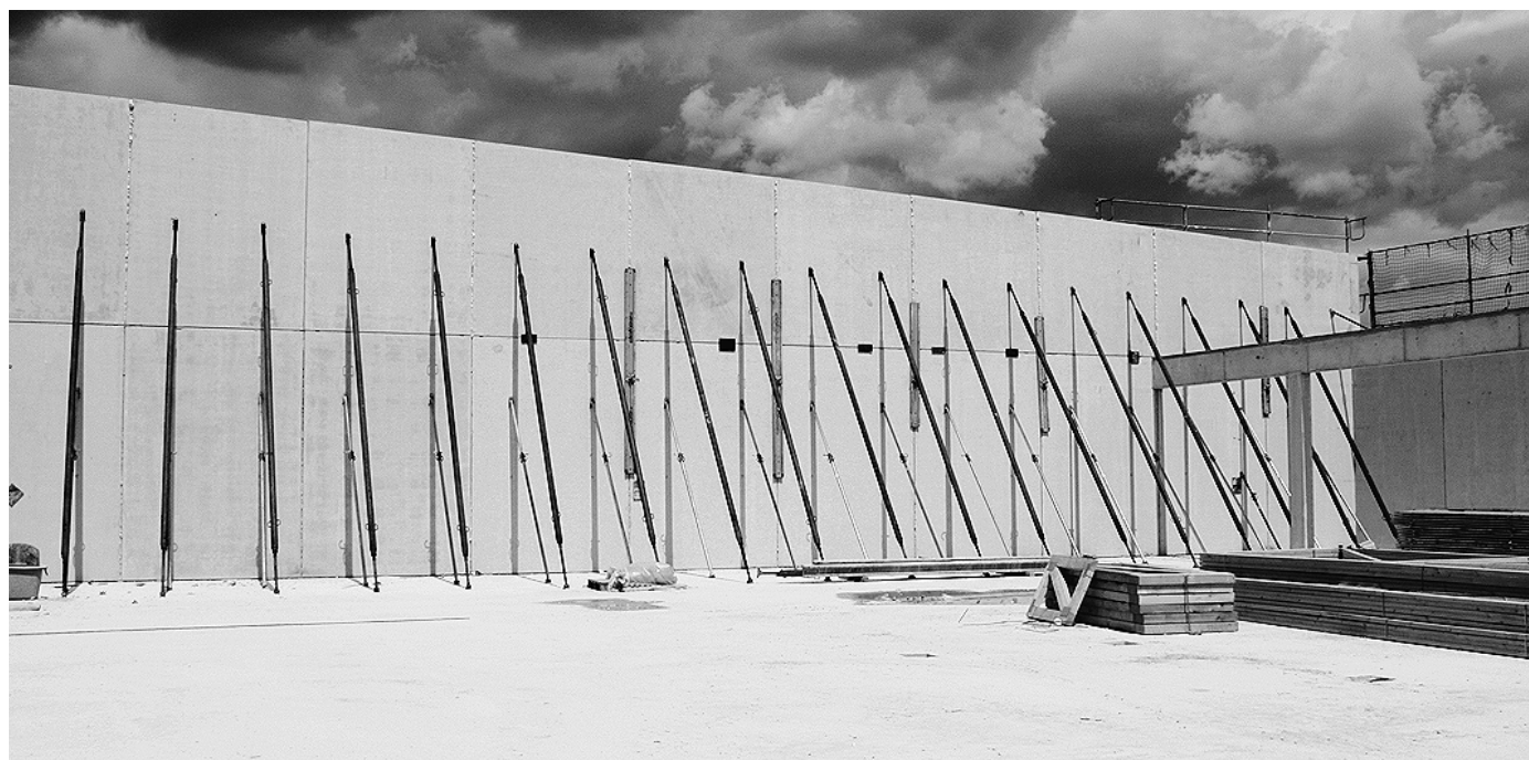
Als Baugerätevermieter lieferte die Firma Walter Lerch aus Frankfurt/Main ca. 250 Schrägstützen in verschiedenen Stütztlängen und Ausführungen bis 7,60 m.
