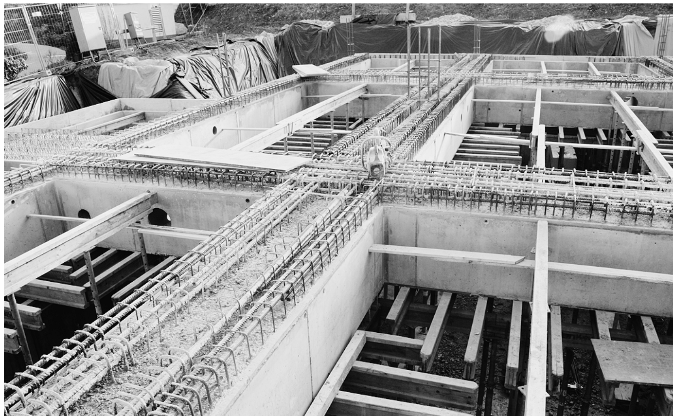
Die Seitenschalung der Unterzüge erfolgte mit Rasto-Schalung.
