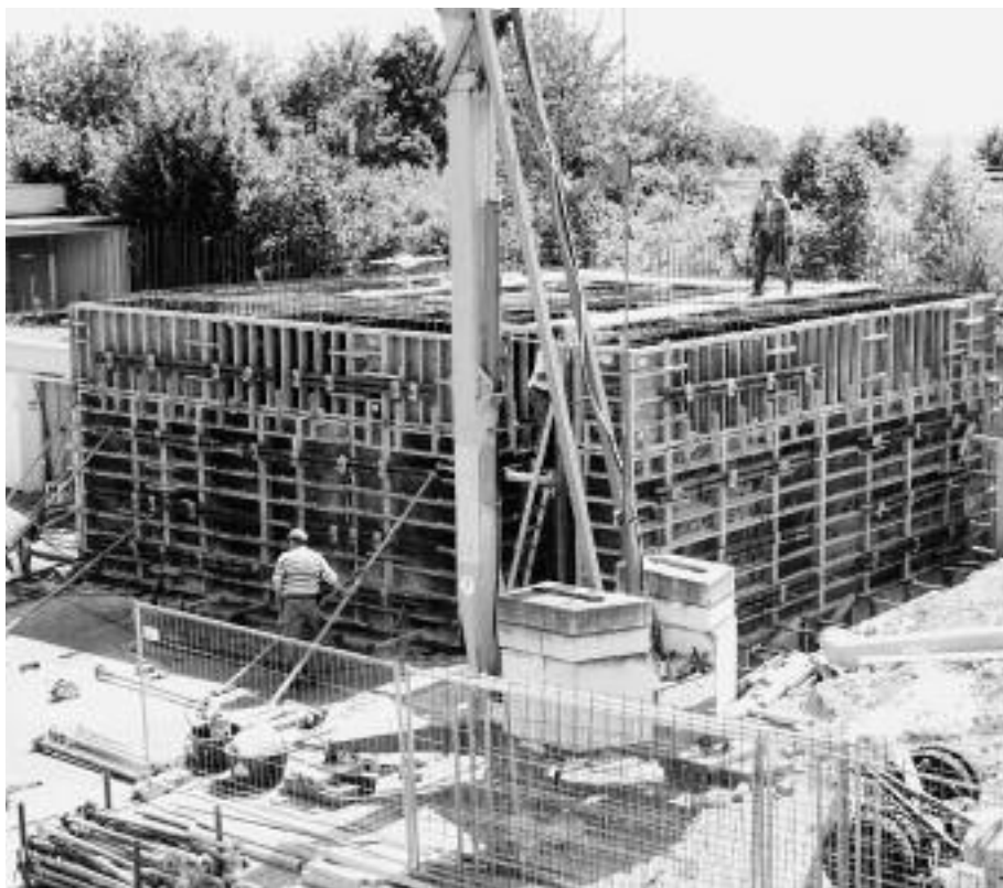
Zum Einsatz kam die schwere Manto-Großrahmenschalung mit einer Schalungshöhe von 3,90 m.
