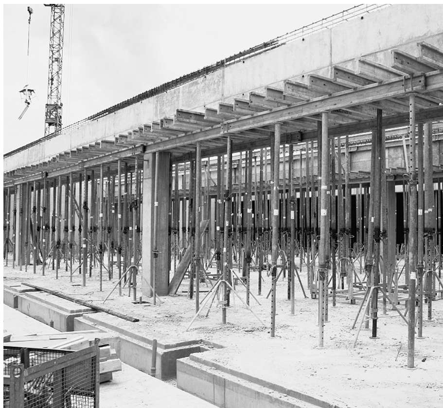
Beim Bau des Edeka-Marktes in Wiesbaden-Auringen wurden ca. 1300 Schwerlaststützen bis 5,50 m für die Abstützung der Filigrandecken eingesetzt. Die Diagonalaussteifung der Stützen wurde kostengünstig mit Verschwerkungsklammern realisiert. Foto: Lerch
