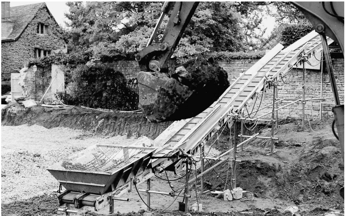
Bei diesem Bauvorhaben wurden zwei Reihen Förderbänder parallel gelegt, da der Aushub mit schwerem Gerät erfolgte.
